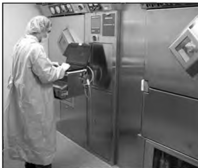
Рис. 3. Лаборатория синтеза 18 F-ФДГ с установленным стационарным защитным оборудованием.
